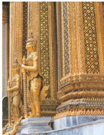
การก่อสร้างเสาแปดเหลี่ยม และเสาข้อมุมไม้สิบสอง ในวัดพระศรีรัตนศาสดาราม กรุงเทพฯ
