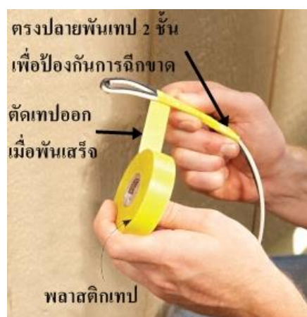
แสดงการซ่อมแซมบัดกรีสายไฟที่ขาดใน พร้อมพันเทปรอบรอยต่อ ป้องกันอันตรายเมื่อใช้งาน
